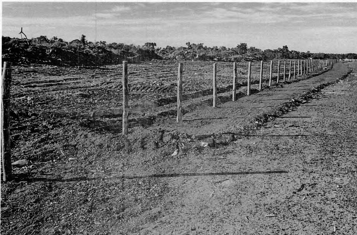
Figura 5 – Parte do cercamento realizado na primeira etapa.
