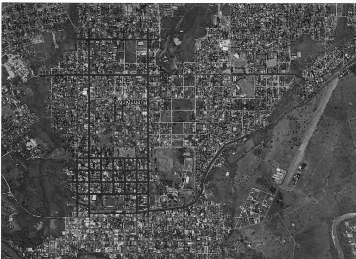
Figura 01 - Destaque da localização da modernização da iluminação Fonte: Google Earth
