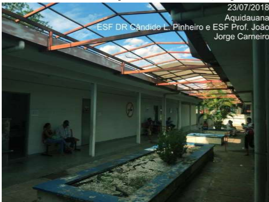
Estrutura de corbetura de policarbinato - Externo | Imagem 03
