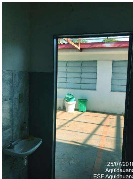
Banheiro Feminino - Externo | Imagem 03
